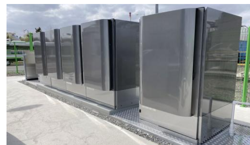
Modulaire waterstofaggregaten
