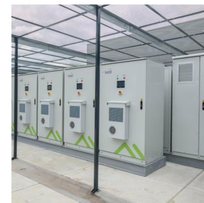
Modulair batterijsysteem
