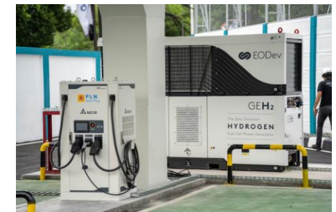
Laadplein gevoed via brandstofcel aggregaat op waterstof
